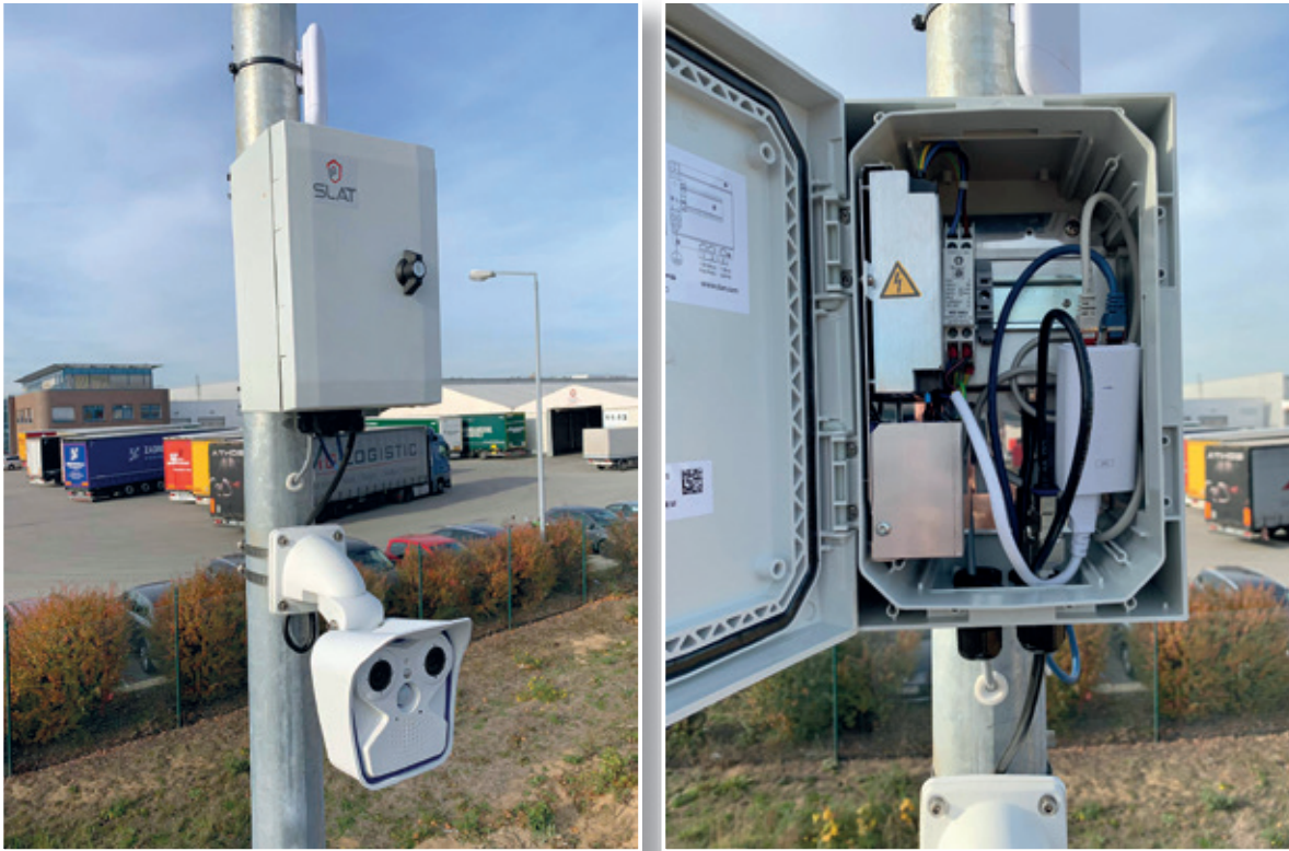
▲ All-in-one-Lösung für eine sichere Videoüberwachung. Outdoor Netzwerkschnittstellengehäuse mit angeschlossener Tag-Nacht-Kamera und WLAN-Bridge
